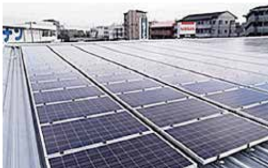
日产神奈川公司的一些经销商使用了太阳能电池板屋顶。太阳能电池板通过 PPS 系统向这些经销商供电。
